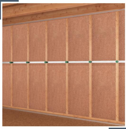
1 Mise en place de la première couche d'isolant Flex entre montants bois
