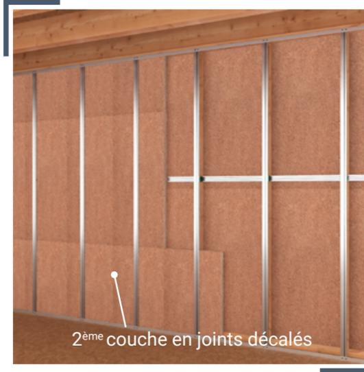
5 Fixation des fourrures verticales en les clipsant directement sur les clés
